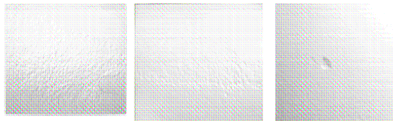
圖十一：一般腐蝕 圖十二：線性腐蝕 圖十三：獨立的坑洞
