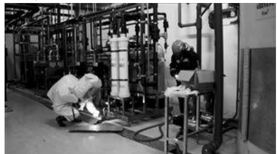
圖二 搶救人員做設備洩漏檢測
