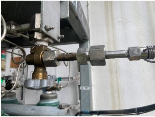
圖二、高壓灌裝軟管使用多組轉接頭，因其重量較重，易使黃銅製瓶閥螺牙產生高應力而損壞
